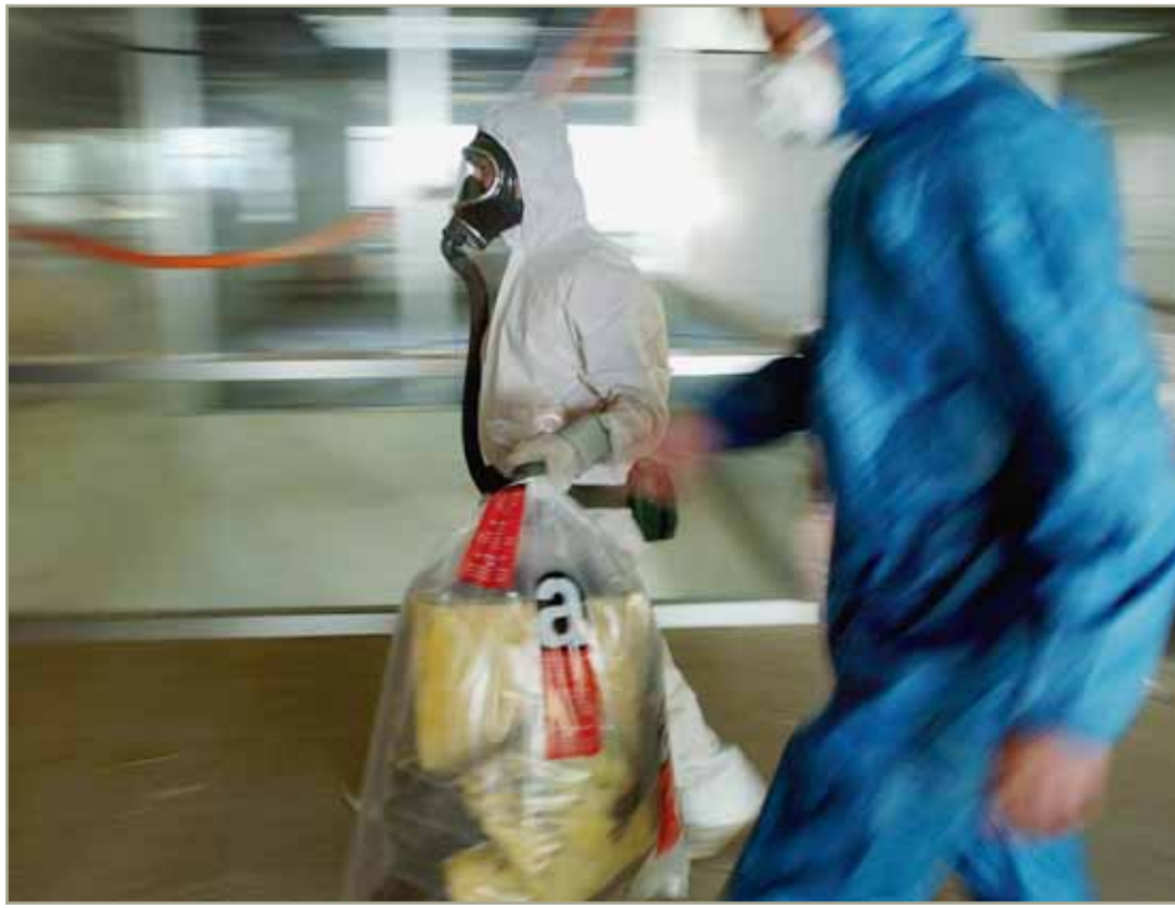
Protection respiratoire et habits spéciaux indispensables pour manipuler de l'amiante. KEYSTONE
